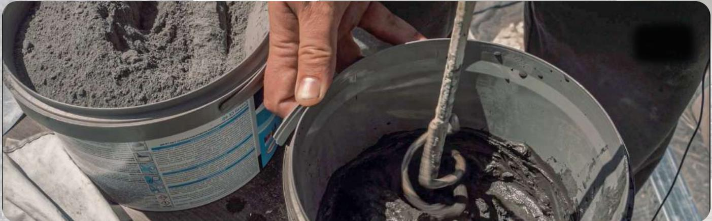
Заполните швы, используя заполнитель в пластиковом пакете или пистолете для герметика. Консистенция должна напоминать пластелин.
