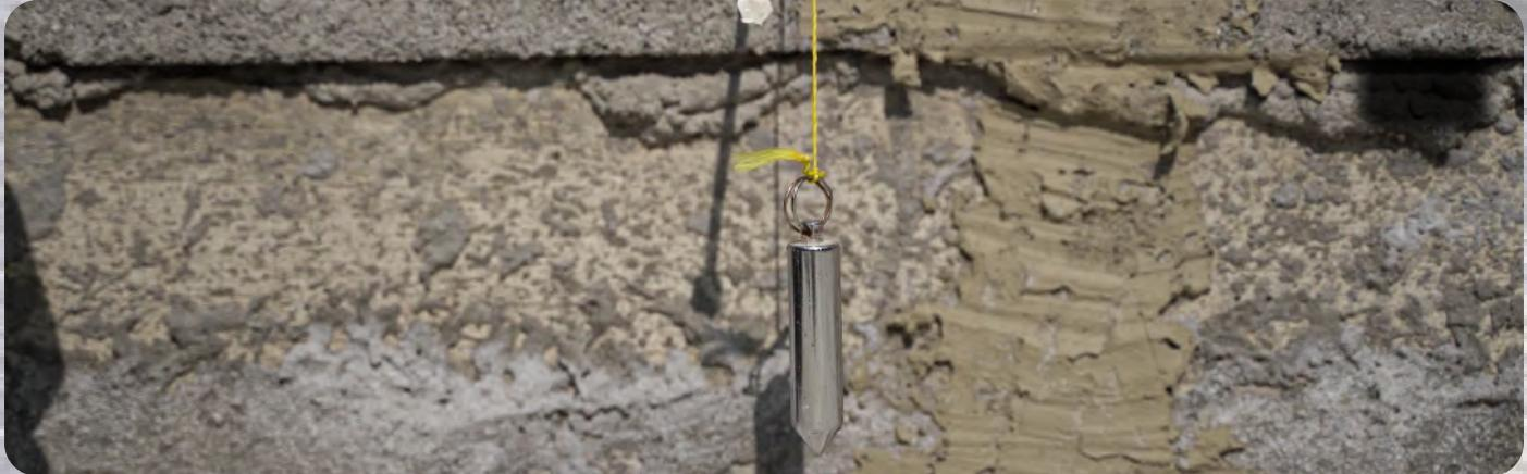
Отмеряем от стены по 6 см, закрепляем расстояния узлами для последующего монтажа миниваты.
