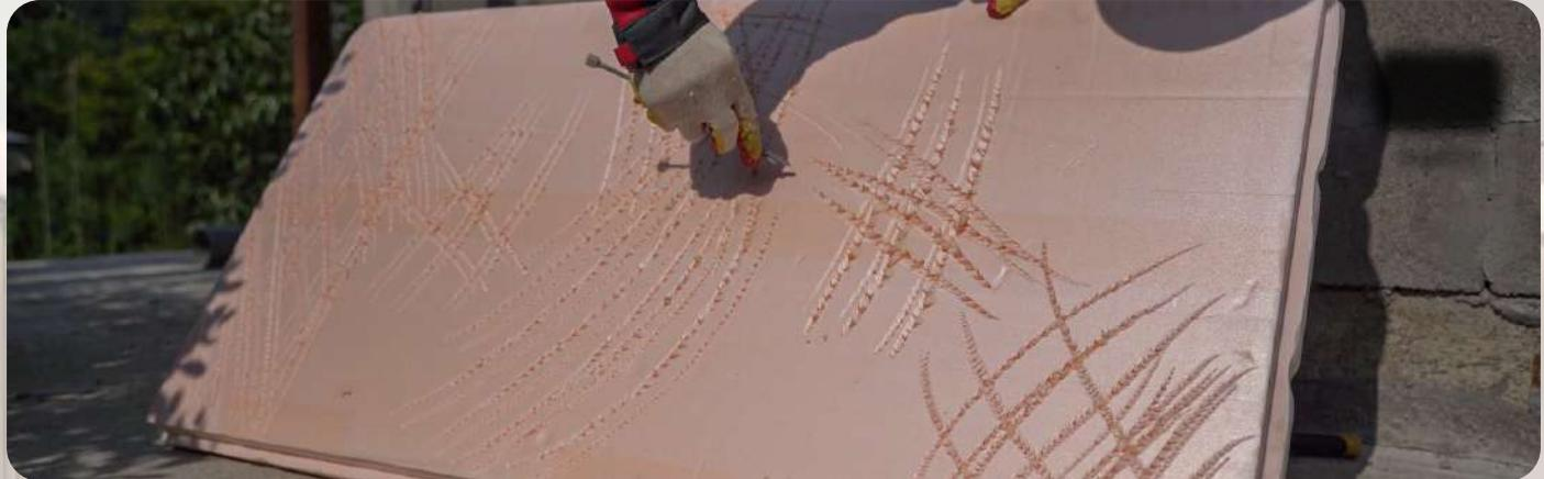
На места порезов наносим клеевую смесь для лучшего сцепления.
